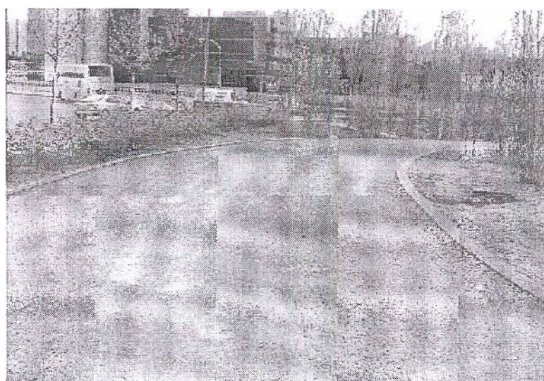
Realización de un camino en jardinería con árido reciclado.
