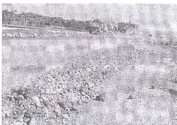
Subbase para cualquier tráfico con árido reciclado
